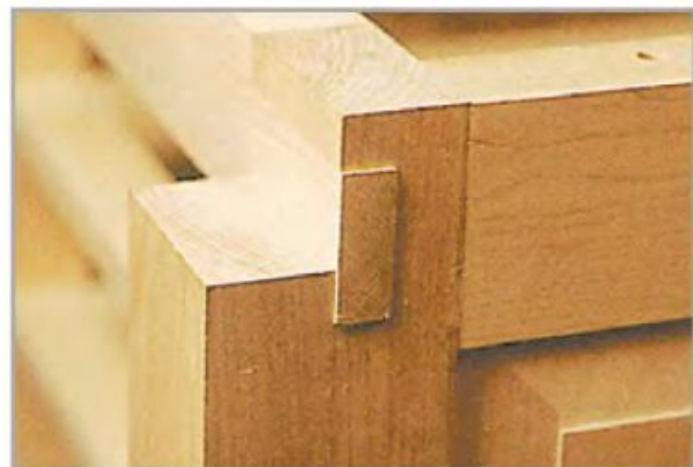
Секрет прочности верстака кроется в тщательности и точности подгонки шиповых соединений горизонтальных перекладин основания с ножками.
