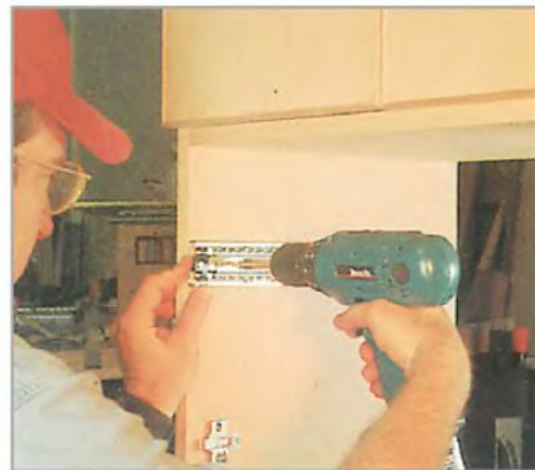
Отступив 5 мм от передней плоскости шкафчика, устанавливают направляющие.
