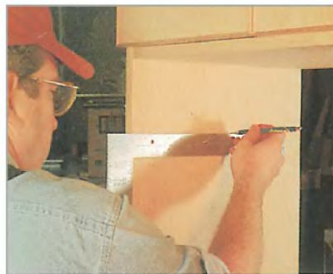
Прикрепив салазки к выдвижному ящику, на стенке шкафчика отмечают положение направляющих.
